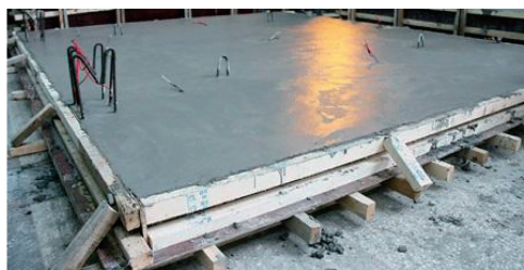
(a) 制作预制外挂墙板
