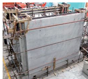
(e) 安装外挂墙板
