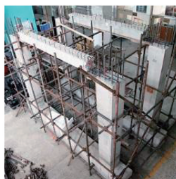
(d) 安装预制梁
