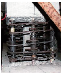
(c) 预制柱纵筋连接
