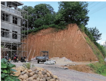
(a) 花岗岩残积层开挖断面
