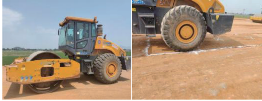
(a) 压路机 (b) 压实过程
