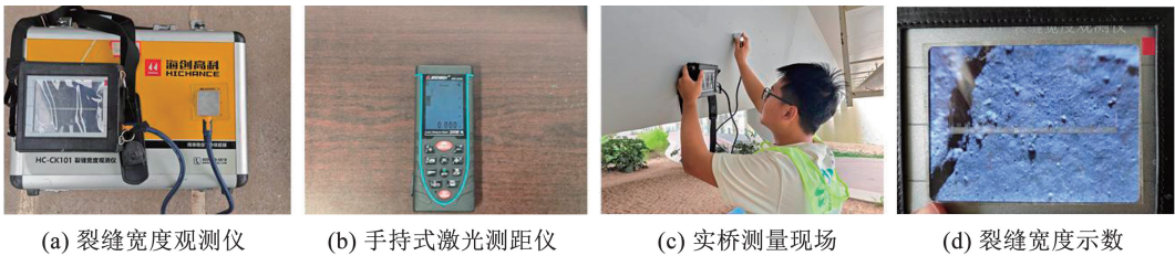
图 11 实桥测试设备及过程
