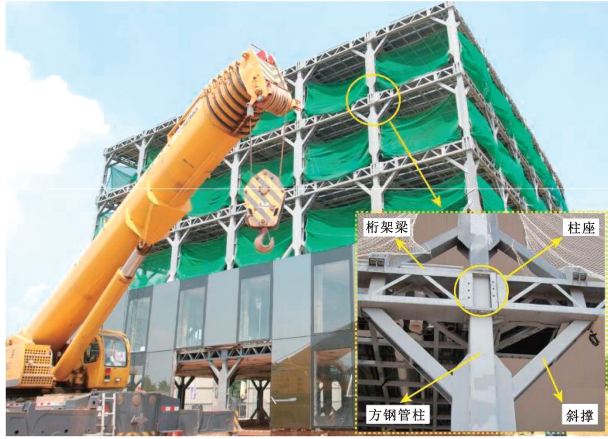
图 1 方钢管柱-桁架梁-斜支撑体系工程应用实例
