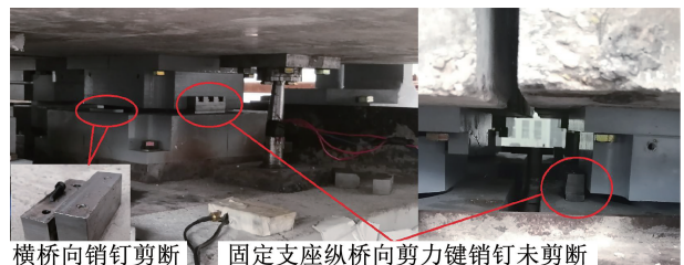
图12 多遇地震下双曲面球型减隔震支座销钉剪断情况
