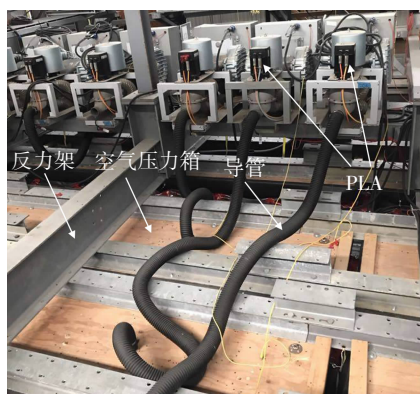
图 3 试验装置安装图 Fig. 3 Test setup
