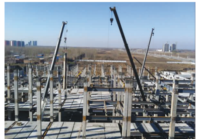
图 1 试点工程的现场施工
