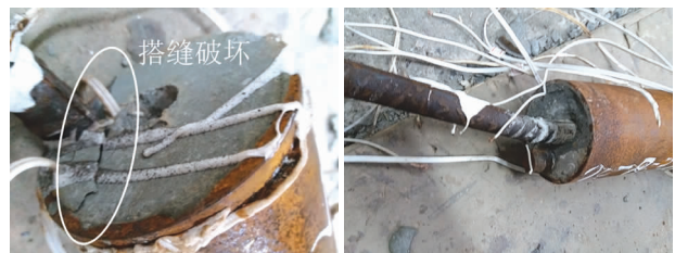
(a) 固定端(预留端)钢筋滑移、 (b) 加载端(后插入端)灌浆料脱落 钢筋搭接间灌浆料开裂
