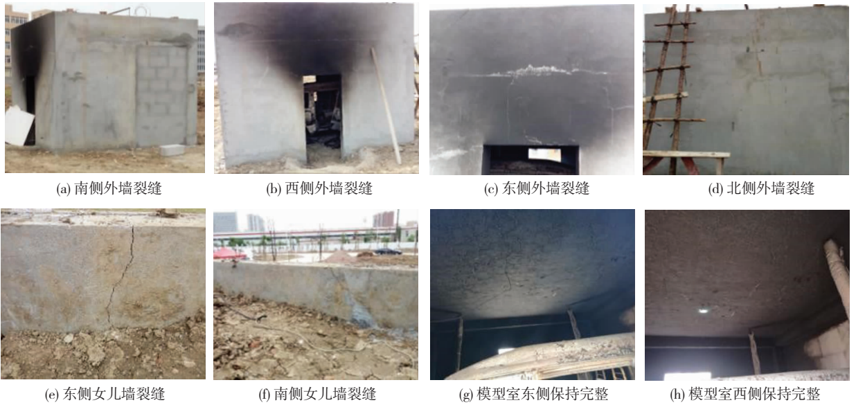
图 12 试验后整体结构受损情况
