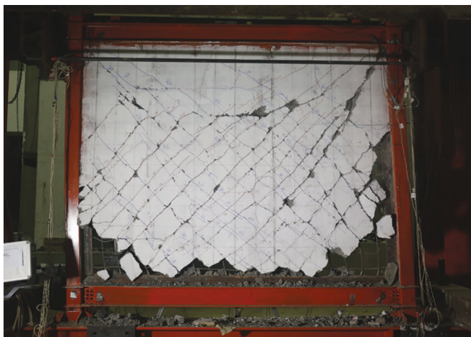
(a) 地聚物混凝土墙体损伤(1/40)
