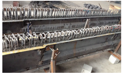
图2 模型梁浇筑
