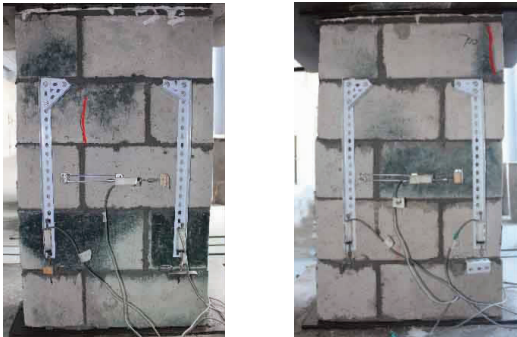
图 4 初裂缝出现位置 Fig.4 Initial crack location
