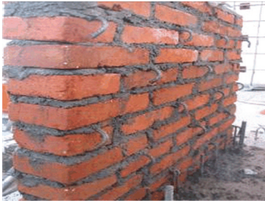
图 4 砖墙中的穿墙筋
