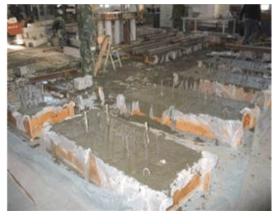
图 3 底梁与顶梁浇筑成型
