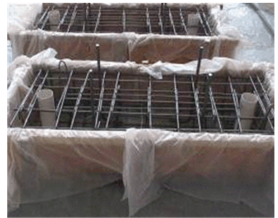
图 2 底梁钢筋骨架
