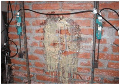
图 5 砖墙应变片及位移计
