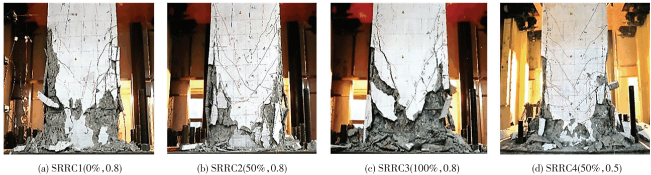
图 6 试件弯剪破坏现象
