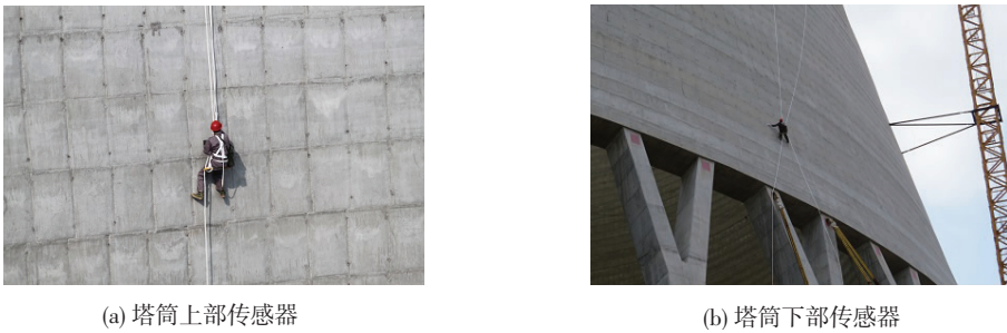
图 3 冷却塔测试现场传感器安装示意
