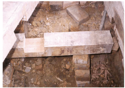
(b) 纳拉杨庙基础拉梁加固
