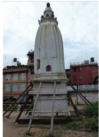
图 15 砖石结构的倾斜
