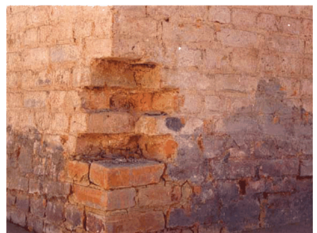
图 22 纳拉杨庙墙体采用了水泥砂浆(KVPT Ranjitkar R K 摄)
