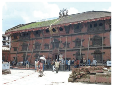
图 10 砖木结构的倾斜
