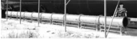
图 3 爆炸管道照片
