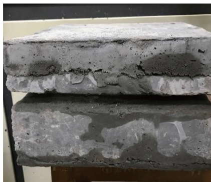
图 2 浇筑后的原状试样
